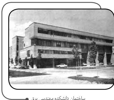
ساختمان دانشکده مهندسی برق
